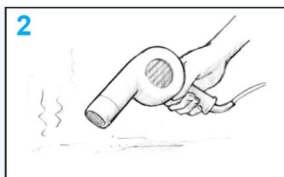
Joonis 7. Kuivatage pind. Laske märgadel pindadel korralikult kuivada või kasutage kuumust või ventilaatorit, et kuivamist kiirendada.
